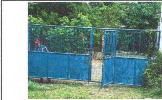
FOTO 10: Sustrucción del portón de metal de ingreso
