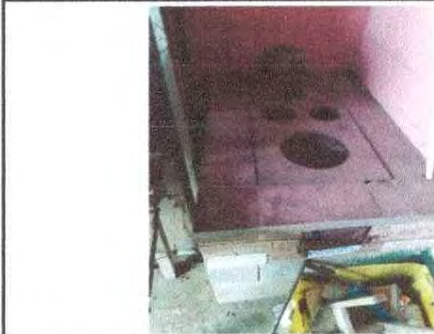
FOTO 7: Sustrucción de estufa rural (completa) incluye chimenea y plancha de metal
