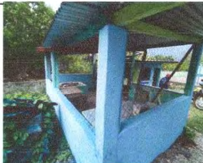
FOTO 4: Sustitución de canal de metal
