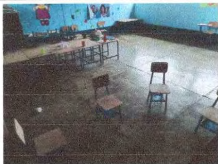
FOTO 13: Sustrución de piso cerámico aula 1
