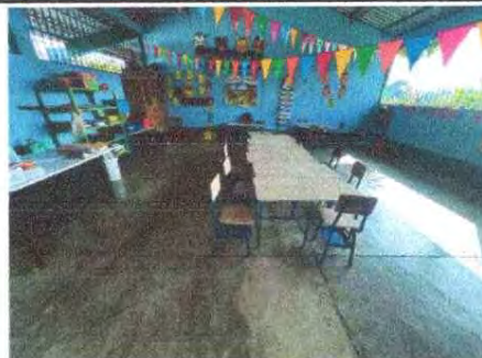
FOTO 14: Sustrución de piso cerámico aula 2
