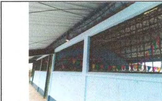
FOTO 11: Mantenimiento a balcones de metal
