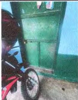
Foto 19. Sustitución de puerta de metal 3
