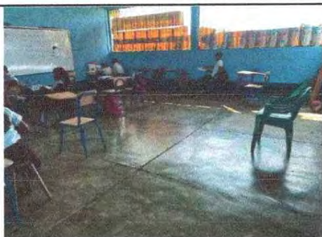
FOTO 15: Sustrución de piso cerámico aula 3
