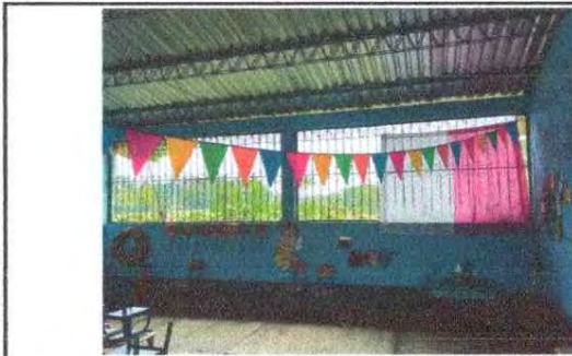
FOTO 12: Mantenimiento a balcones de metal.
