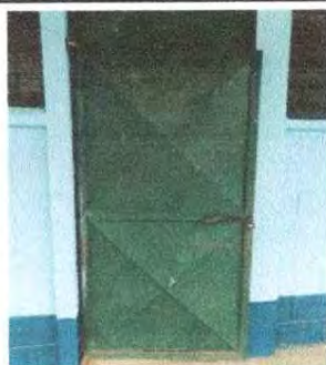
Foto 17. Sustrución de puerta de metal 1
