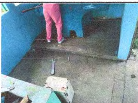
FOTO 3: Sustitución de piso cerámico
